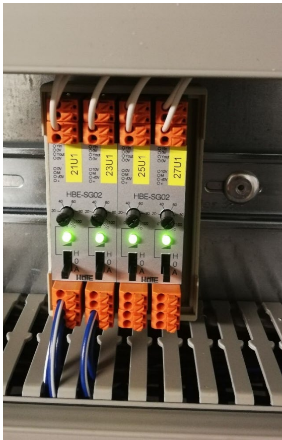
Bild: Beispiel von LVB im Schaltschrank
